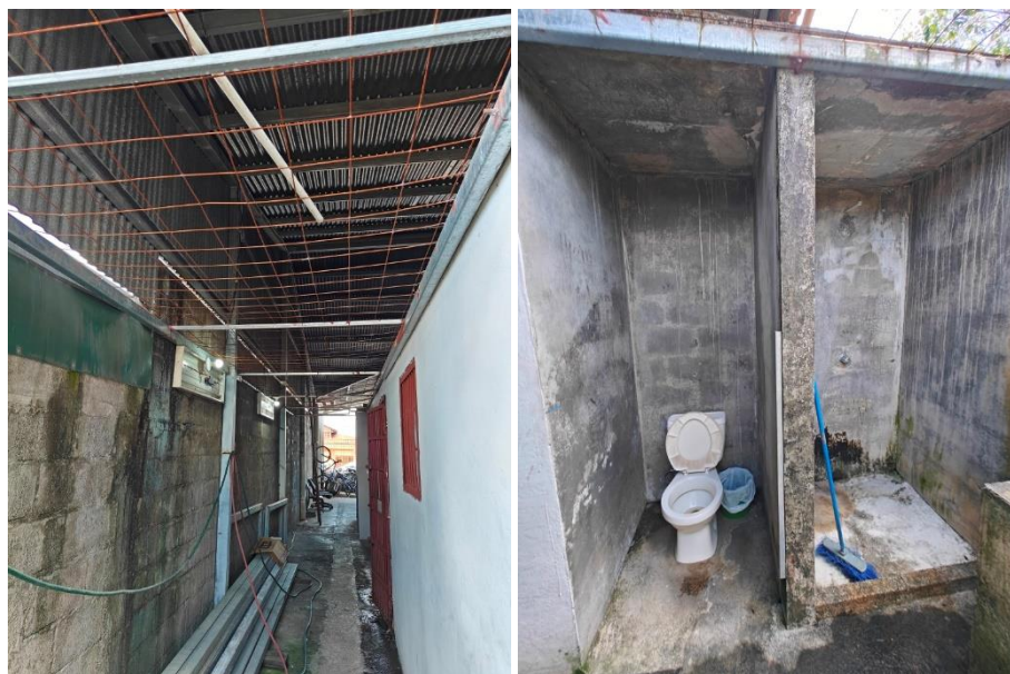
Fotos: izquierda, malla electrosoldada instalada; derecha, área de baño y duchas.
