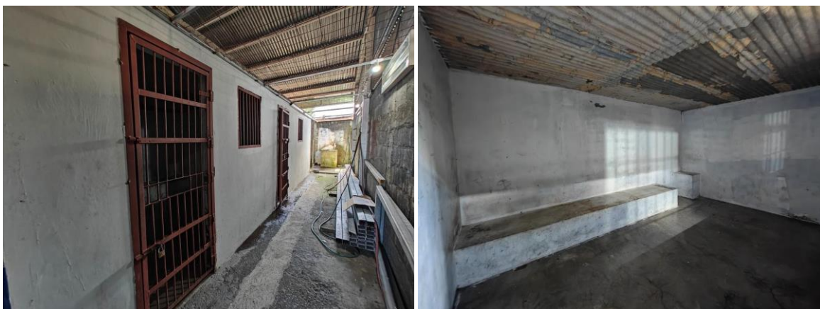
Fotos: izquierda, área exterior de celdas; derecha, interior de celdas.
